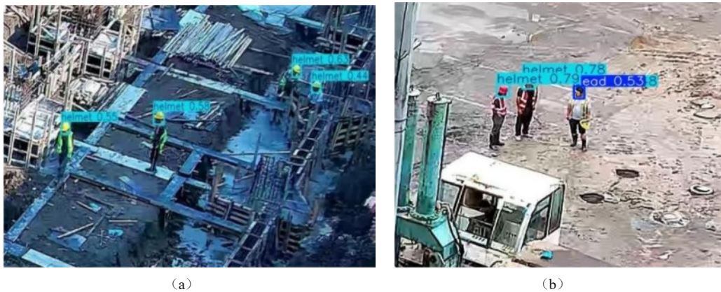
图 10 建筑工地现场实际检测结果
